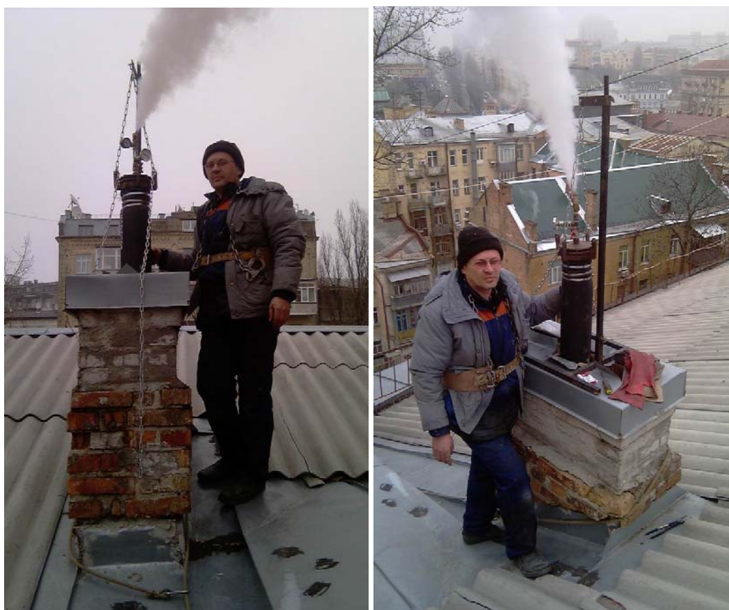
Рис.7 Фрагмент установки трубы. Клапан верхнего адаптера стравливает избыточное давление.
