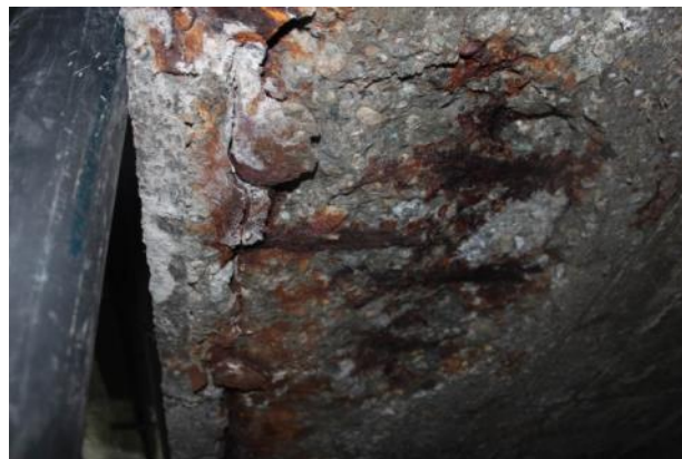
Рис. 4. – Вскрытие конструкции чаши бассейна с нижней стороны для определения состояния имеющегося армирования.
