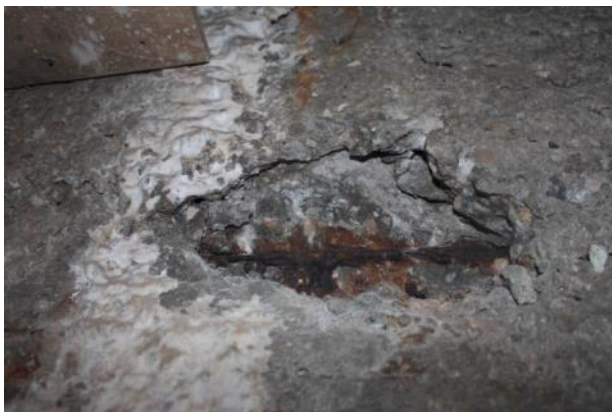
Рис. 3. – Вскрытие конструкции чаши с боковой стороны для определения состояния имеющегося армирования чаши бассейна.
