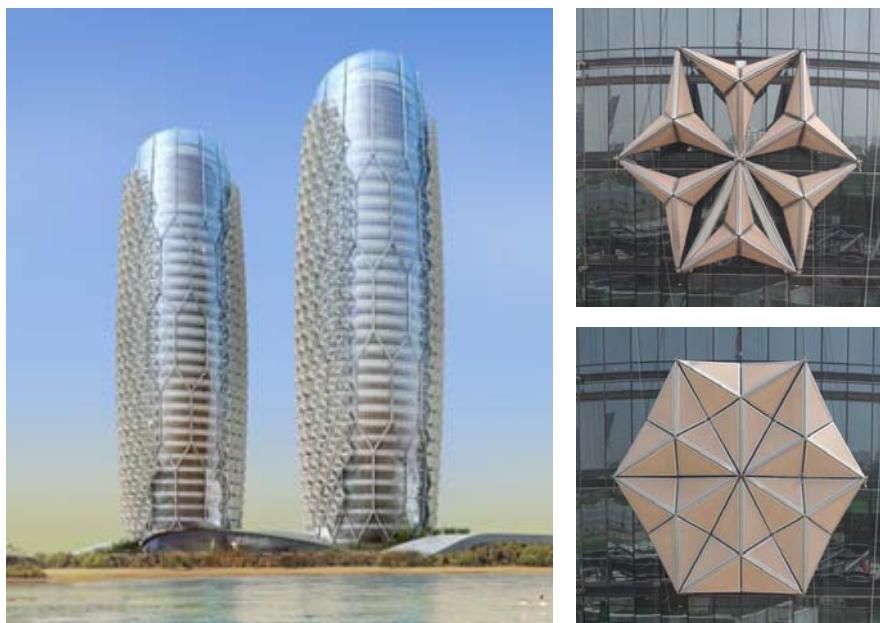
Рис. 5. [9] – Башни Аль Бахар, г. Абу-Даби, ОАЭ, архитектурная компания Aedas Architects. Общий вид. Трансформируемые элементы
