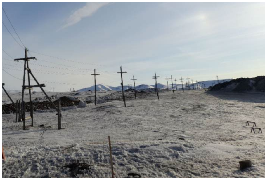
Фото 1. Общий вид деревянных опор ВЛ-6кВ. (6-17, 24-34).
