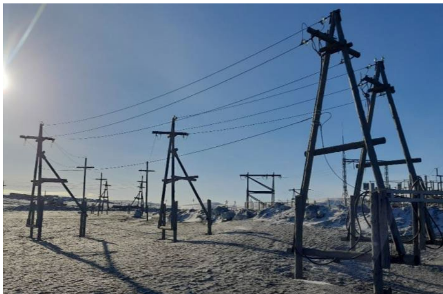
Фото 2. Общий вид деревянных опор ВЛ-6кВ. (1-5, 18-23)
