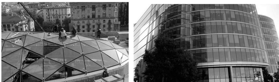
Рис. 2 – Сборка криволинейных витражных конструкций из плоских треугольных[11] и четырехугольных[12] элементов.
