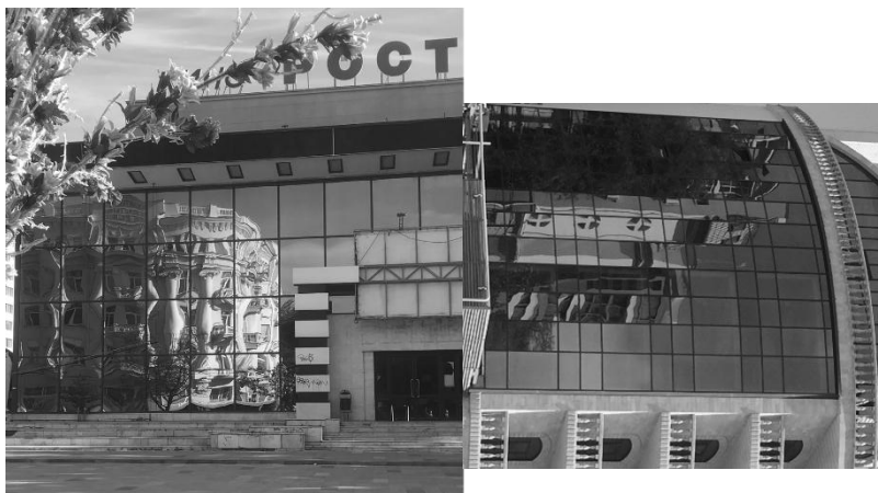
Рис.3 – Примеры деформации (линзования) стеклопакетов на фасадах зданий, г. Ростов-на-Дону (фото автора).
