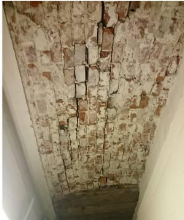
Рис. 4. Схема характерных дефектов сводов до усиления
