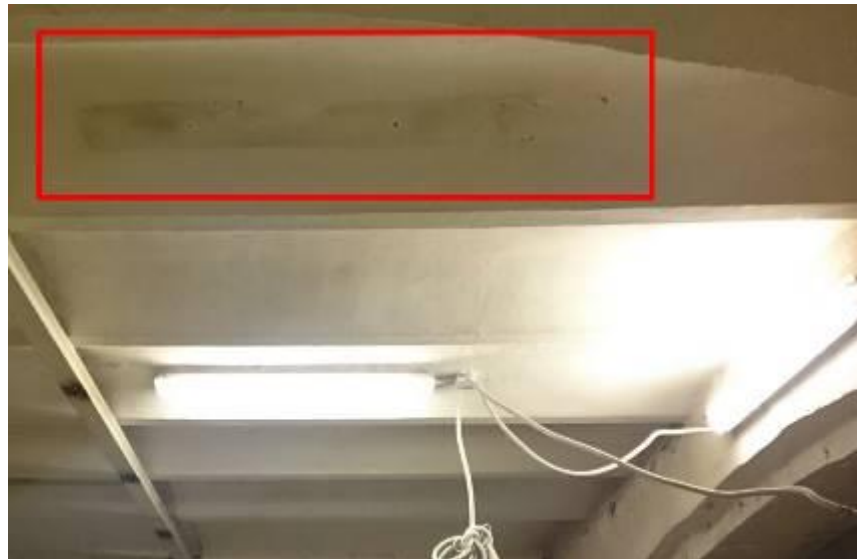
Рис. 5. Общий вид свода после усиления по нижней грани внешним армированием.
