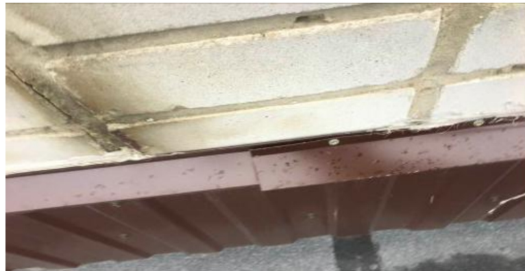
Рис.2 Внешний вид примыкания к стене прижимной планки
