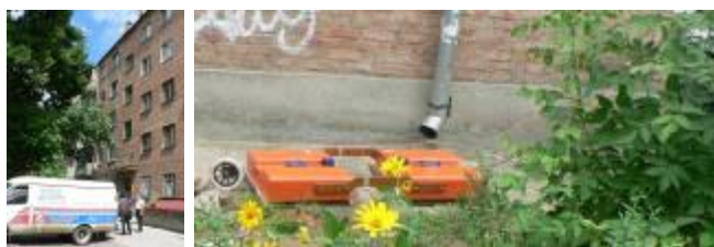
Рис. 1. – Фасад здания по оси В
